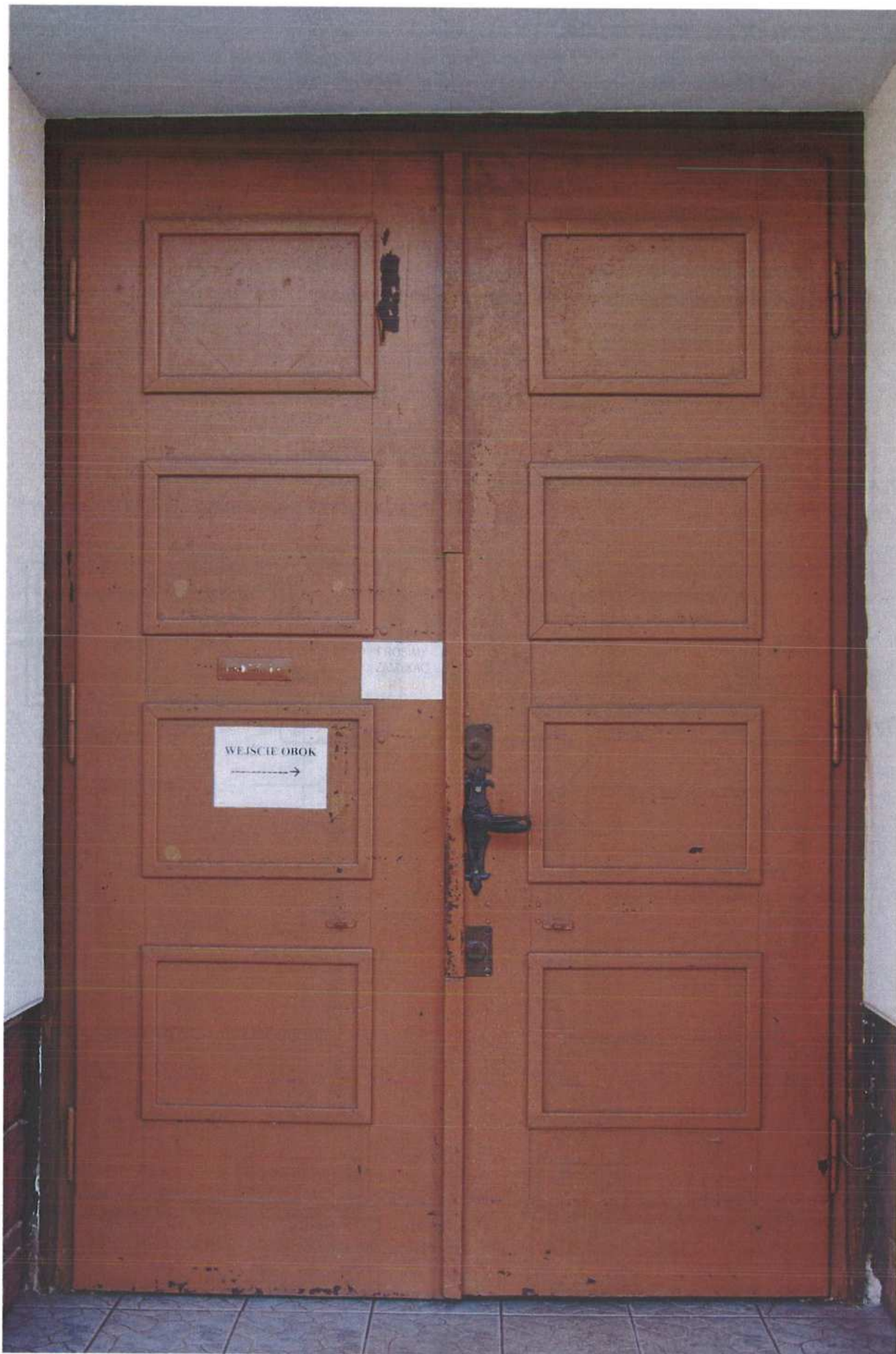
Awers drzwi Dz1 – główne drzwi wejściowe.
