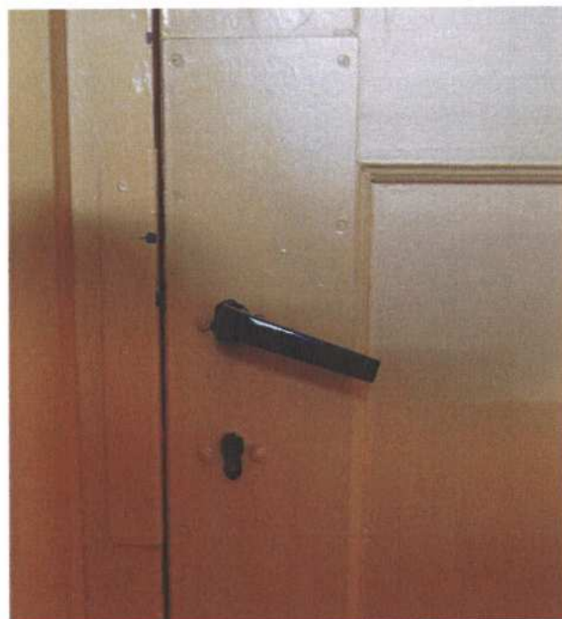
Drzwi D3 – wtórna klamka na wtórnym podkładzie.
