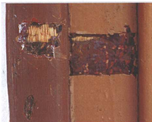
Odkrywka Dz2a.1 na opasce ościeżnicy przy zawiasie po zewnętrznej stronie drzwi
