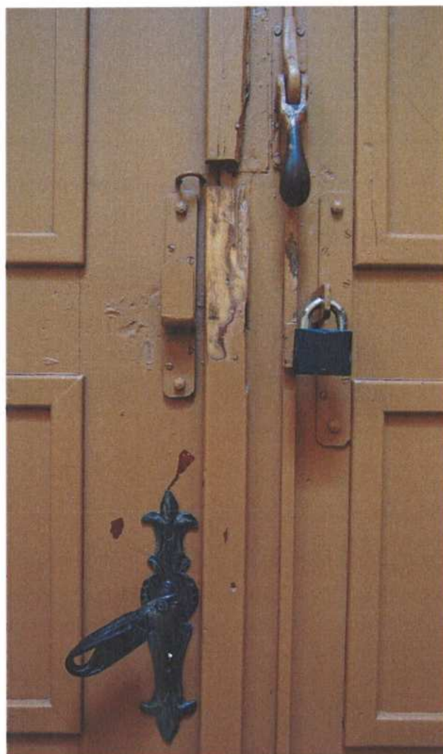
Rewers drzwi Dz2b. – wtórna klamka oraz kłódka i mocowanie poziomego rygla. Widoczne uszkodzenia listwy przymykowej.
