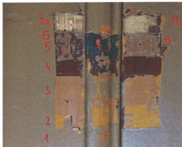
Odkrywka D1.2 skrzydło drzwiowe na ramiaku z profilowaną krawędzią i na płycinie
