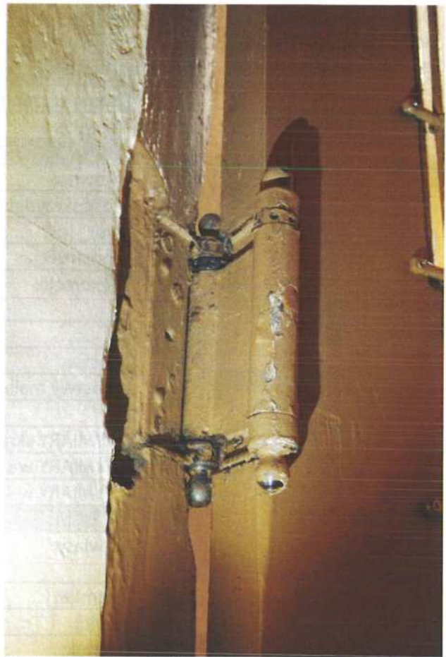
Drzwi D1. – zawias wahadłowy przemalowany w paru warstwach.
