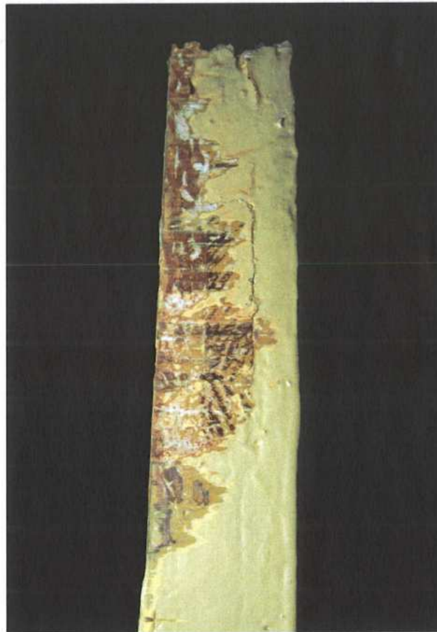
Drzwi D5, fragment skrzydła z przetartymi warstwami farby – widać klejoną konstrukcję z drewna iglastego.
