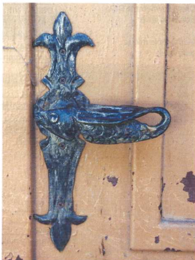
Awers drzwi Dz2a – wtórna klamka montowana na śruby i słaby ślad starszego szyldzika.
