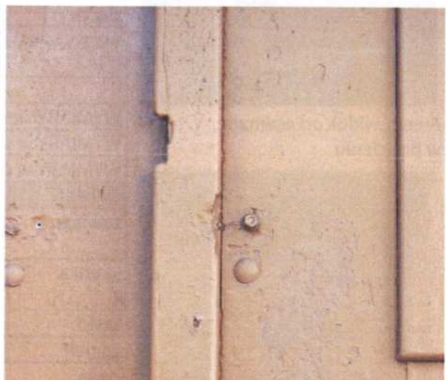
Awers drzwi Dz2b – śruby z wtórnego montażu zamków.
