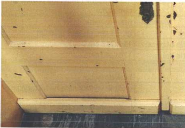
Drzwi D4, szpara przy wtórnie zamontowanej listwie u dołu drzwi.
