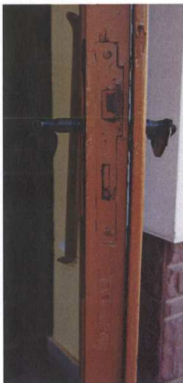
Drzwi Dz2b – zamek wewnętrzny, montaż na śruby.
