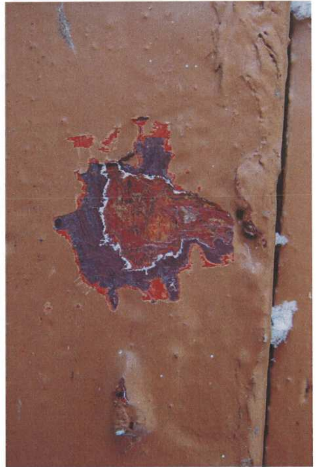
Drzwi Dz4 – fragmenty drzwi, widoczne uszkodzenia , zły stan zachowania drewna ościeżnic oraz nawarstwienia farby.
