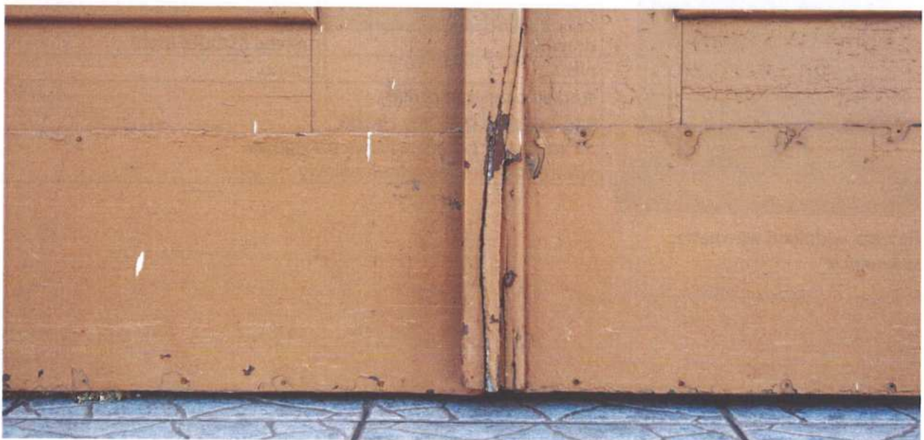
Awers drzwi Dz2b – wtórnie przymocowany kopnik i przemalowany oraz spękania listwy przymykowej.
