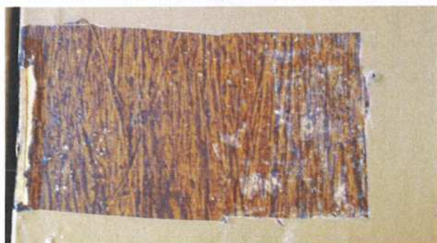
Odkrywka ukazująca mazerunek na ramiaku i ościeżnicy
