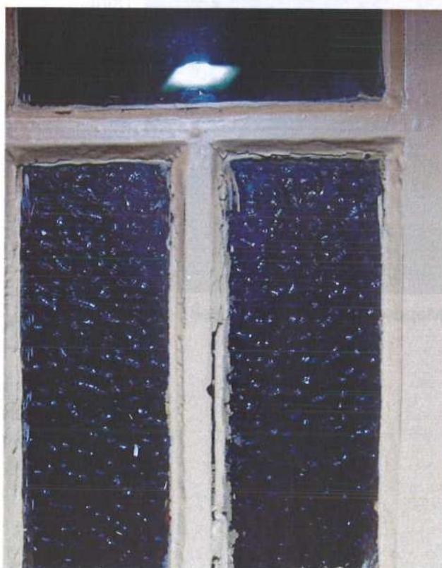
Drzwi D5, wtórne szyby w drzwiach o różnym charakterze.
