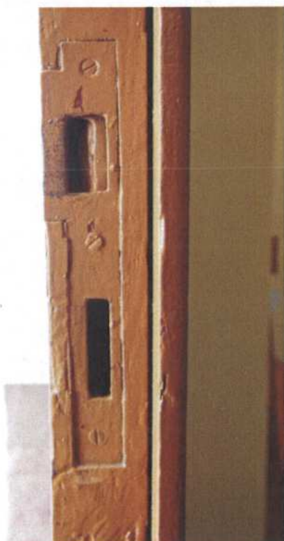
Drzwi Dz2b – zamek wewnętrzny, montaż na śruby.
