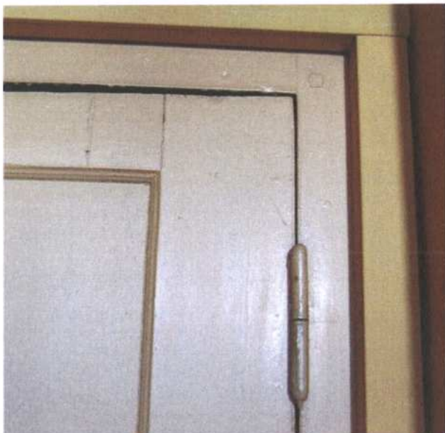
Drzwi D3 – górny fragment z widocznym przycięciem, oryginalne zawiasy.
