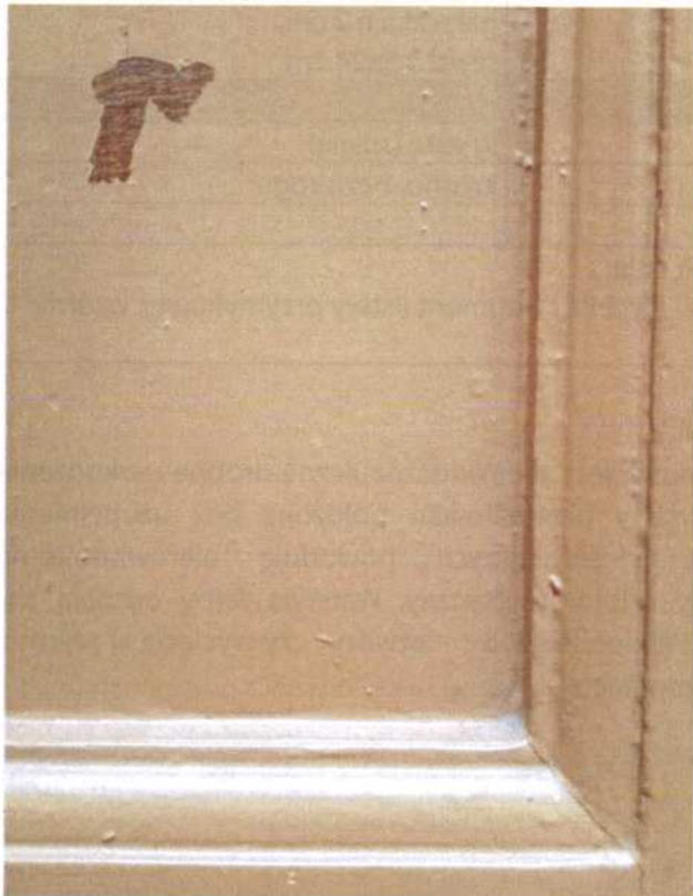
Drzwi D2b – naturalna odkrywka ukazująca mazerunek na płycinie w układzie poziomym włókien malowanego drewna.
