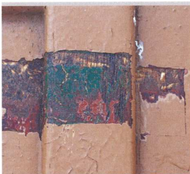
Odkrywka Dz2b.2 awers, odkrywka na płycinie, prentawinie i ramiaku
