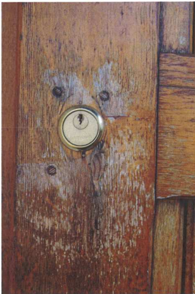
Drzwi Dz3 – fragmenty okuć na drzwiach oraz widoczny zły stan zachowania powierzchni drewna.
