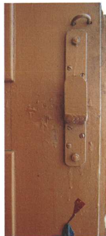
Rewers drzwi Dz2b. – wtórna klamka oraz kłódka i mocowanie poziomego rygla. Widoczne uszkodzenia listwy przymykowej.
