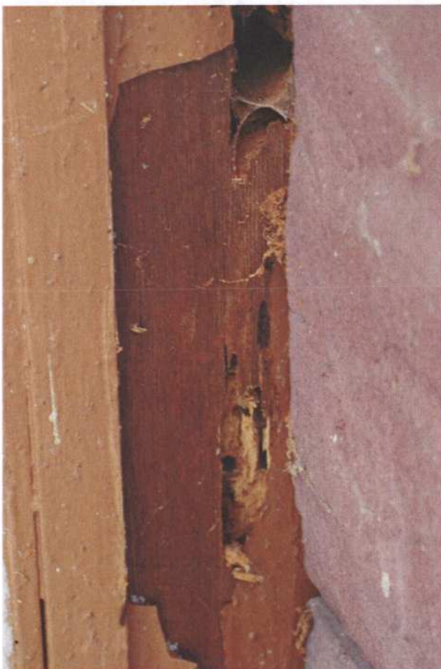
Drzwi Dz4 – fragmenty drzwi, widoczne uszkodzenia , zły stan zachowania drewna ościeżnic oraz nawarstwienia farby.
