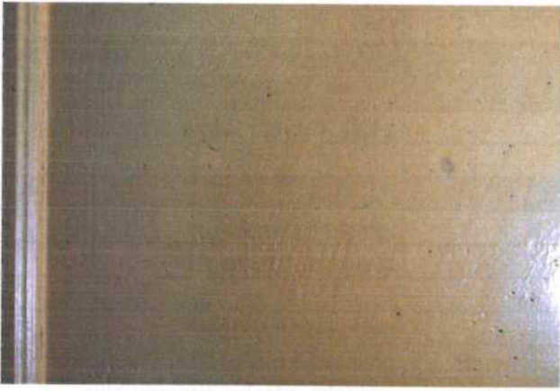
Drzwi D4, widoczne zamalowane ślady po żerowaniu ksylofagów.
