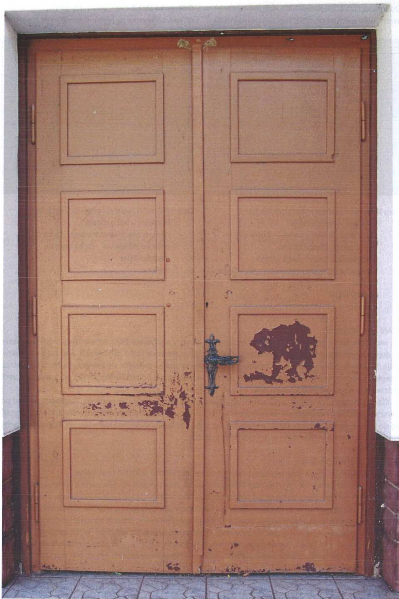
Awers drzwi Dz2a – drzwi wejściowe po lewej stronie, drzwi zaryglowane od wewnątrz i zamurowane ścianką gipsową.
