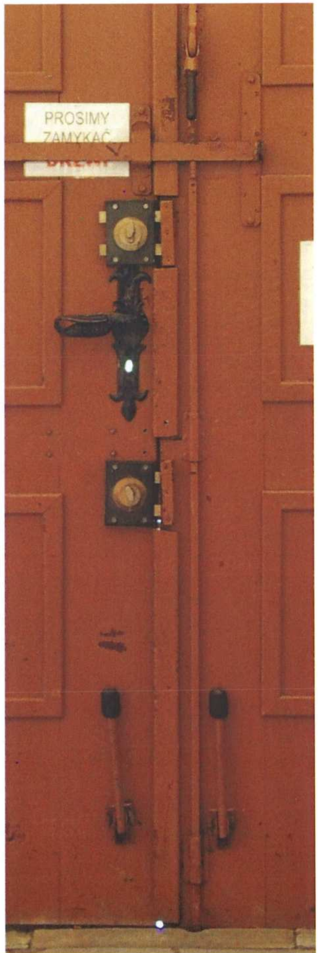
Rewers drzwi Dz1, wtórne zamki, klamka, rygiel poziomy oraz nóżki.
