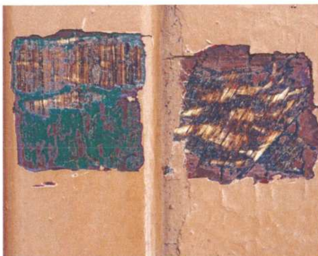
Odkrywka D2a.2 na prentawinie i płycinie
