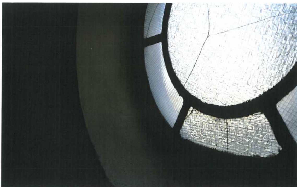
fot. 13 wieża poziom chóru
