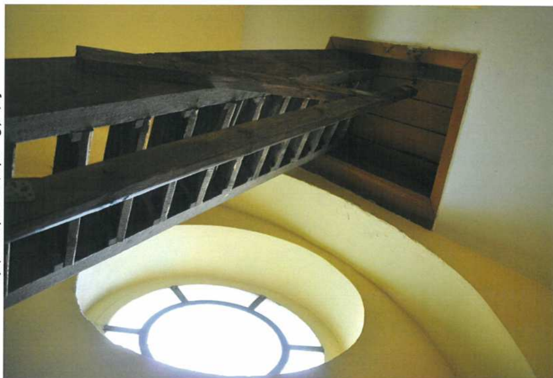
fot. 12 - wieża poziom chóru
