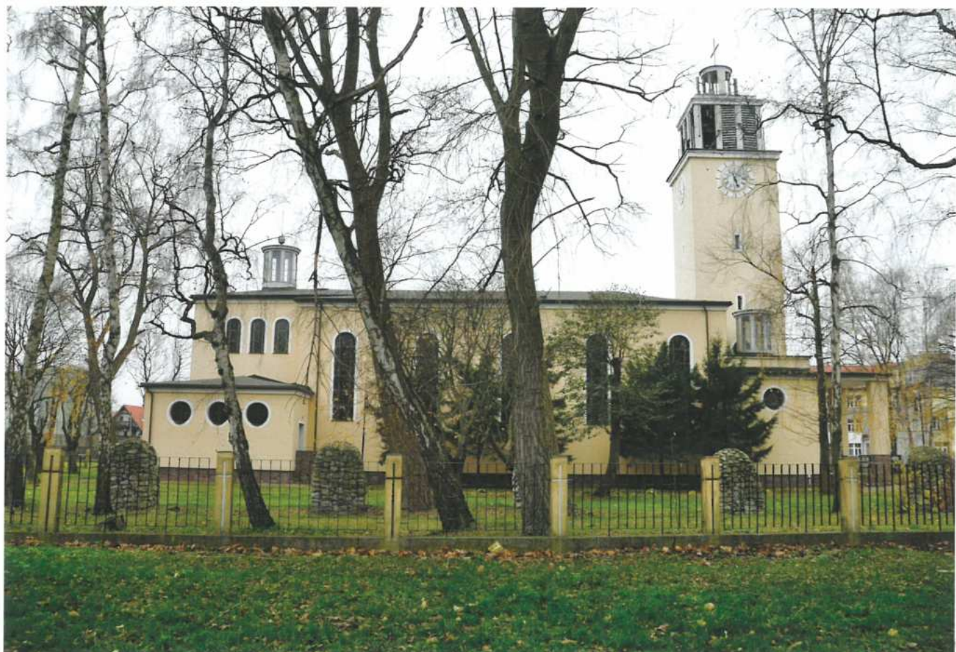
fot. 2 - elewacja wschodnia
