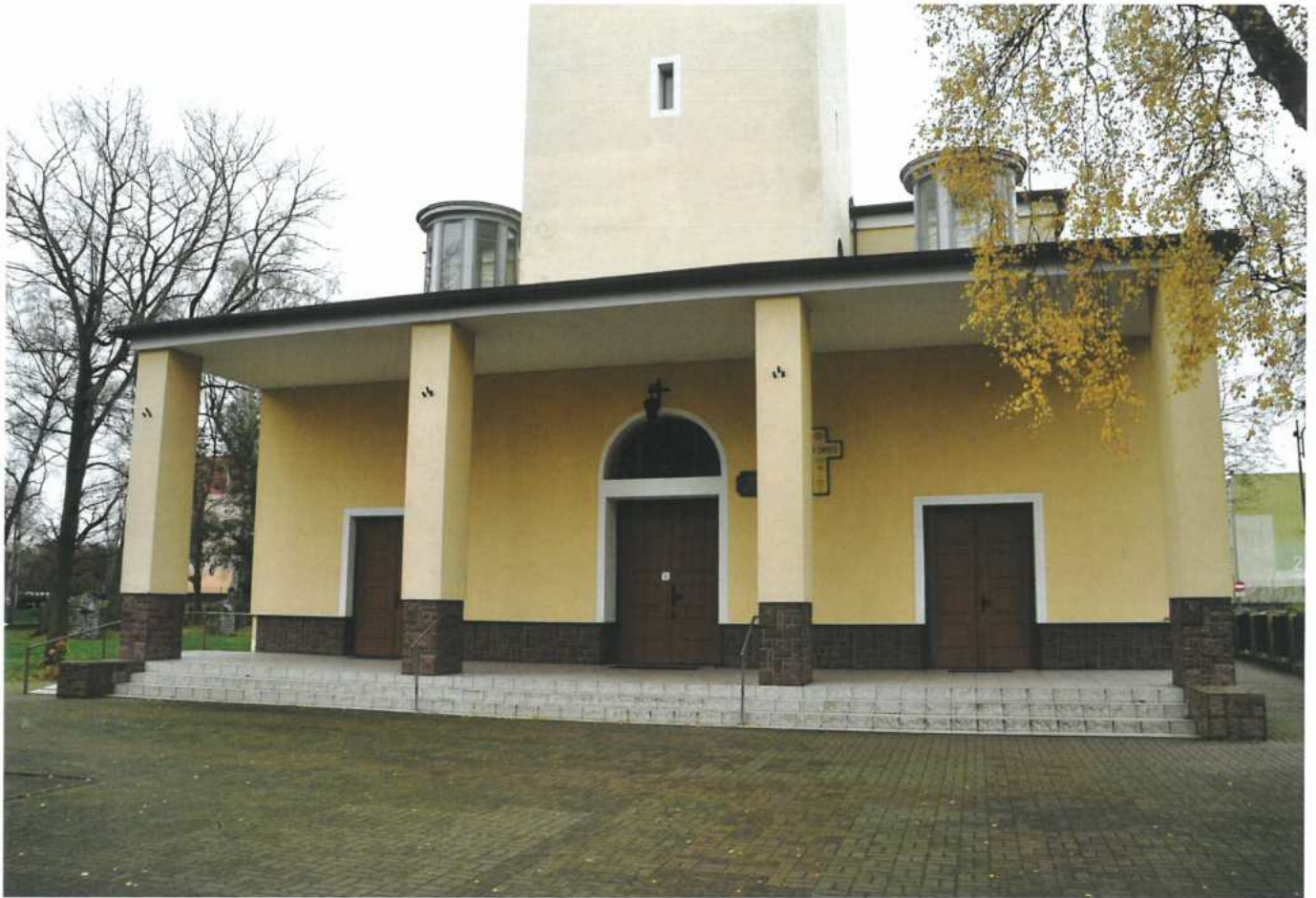
fot. 3 - elewacja północna - wejście główne
