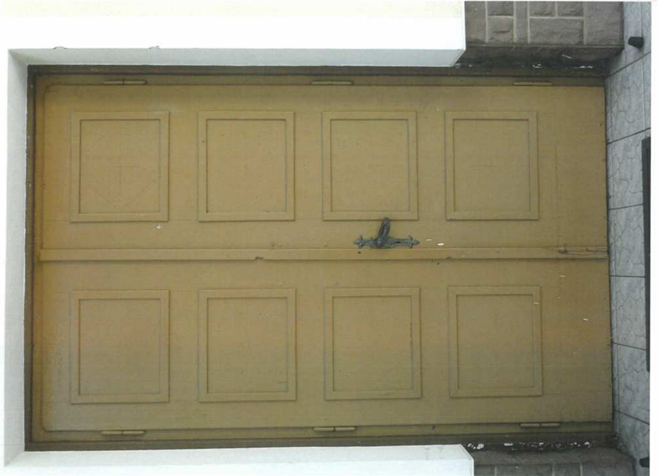
fot. 24 - drzwi - boczne wejście do kościoła Dz2
