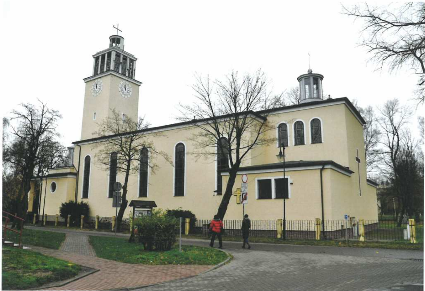
fot. 1 - elewacja zachodnia
