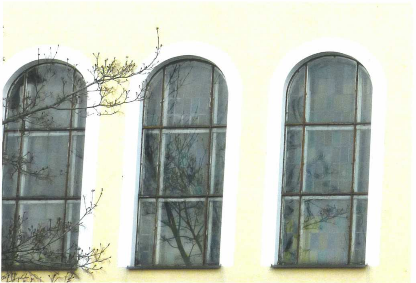
fot. 9 - istniejące okno O2
