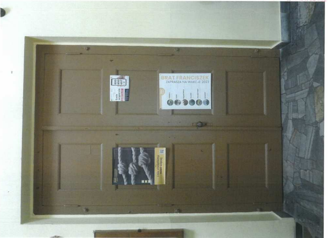
fot. 19 - kruchta drzwi boczne D2
