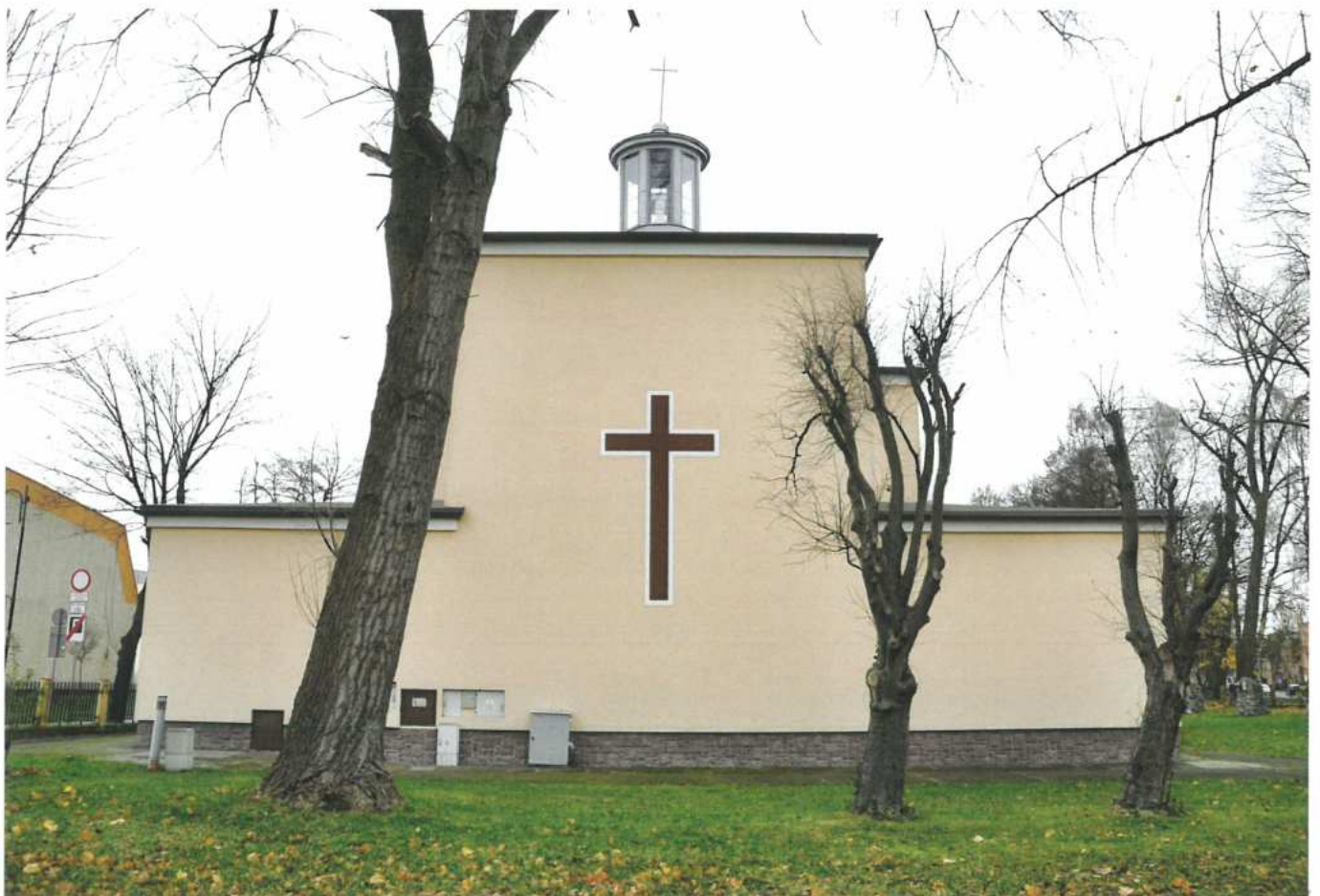
fot. 4 - elewacja południowa
